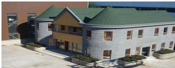
Рис. 1. Напечатанный на 3D принтере дом
