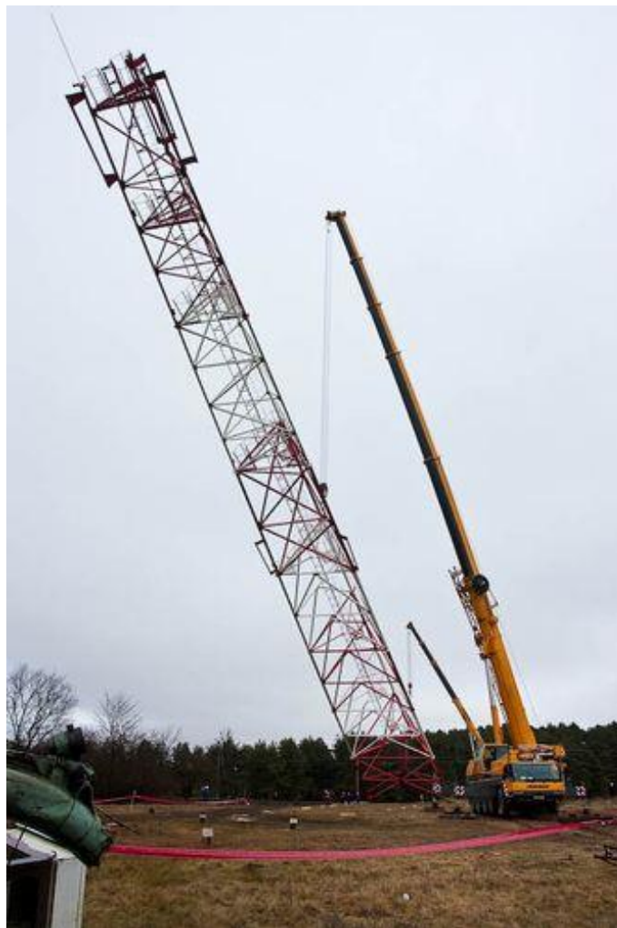
Рис. 1. Установка вышки сотовой связи
