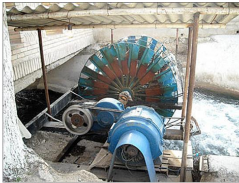
Рис. 2 ГЭС деривационного типа
